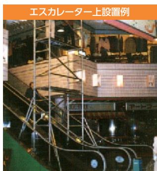
エスカレーター上設置例 3段セット以上の組立・解体には「足場の組立等作業主任者」の講習を受講された方の立会いが必要です。
